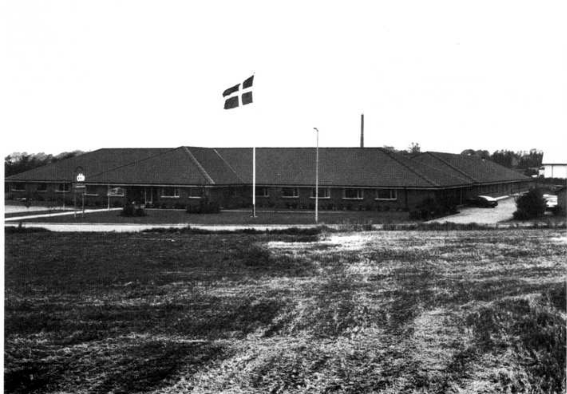
DDE's produktion af Supermax-datamater foregår i Klokkerholm nord for Ålborg. Den første del af fabriksbyggeriet blev færdig i 1981. Med en udvidelse tre år senere kom det totale bebyggede areal op på de nuværende 3500 m 2 .
