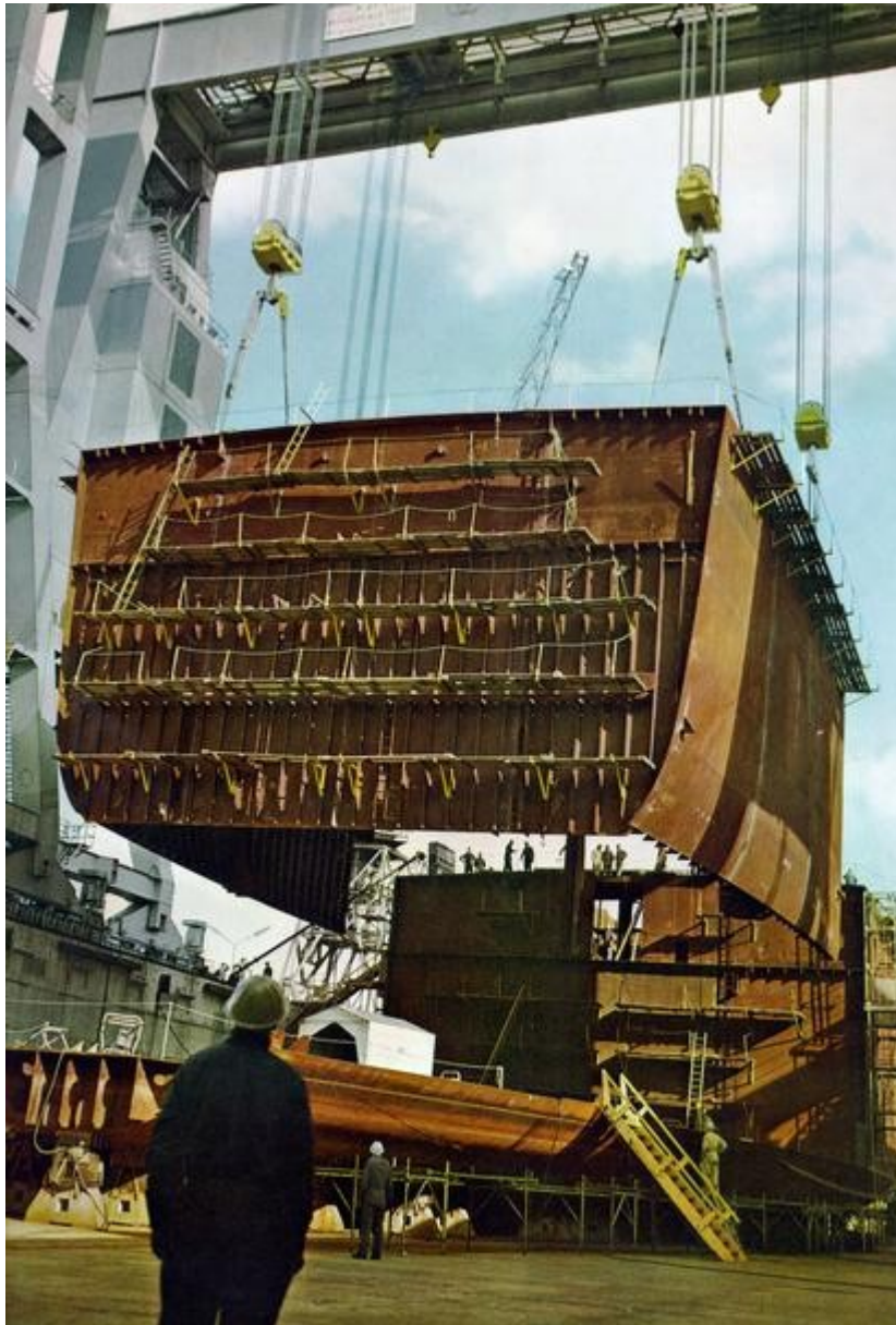
Burmeister & Wain har rationaliseret sin produktionsteknik og bygger skibe i »skiver«. Såvel teknisk som administrativt er denne nye produktionsform baseret på anvendelse af EDB-anlæg.
