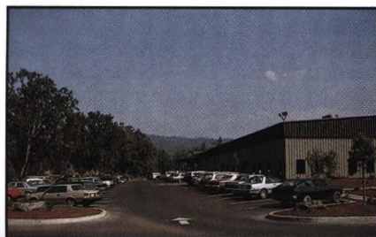
Sierra On-Line's nye hovedbygning i Coarsegold i Californien.
