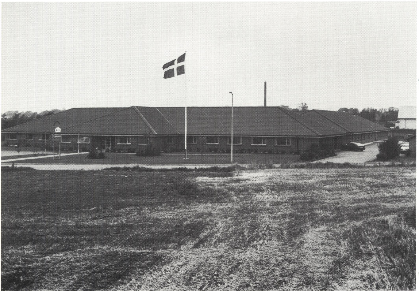
DDE's produktion af Supermax-datamater foregår i Klokkeholm nord for Ålborg. Den første del af fabriksbyggeriet blev færdig i 1981. Med en udvidelse tre år senere kom det totale bebyggede areal op på de nuværende 3500 m 2 .
