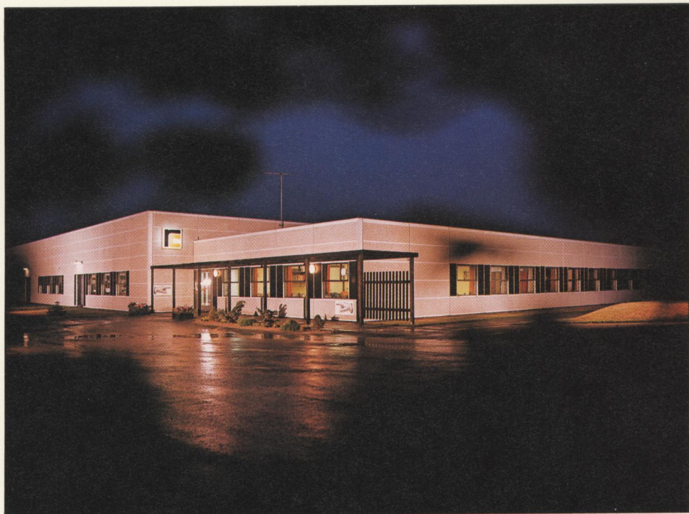
RC's factory in Præstø, 80 km south of Copenhagen.
