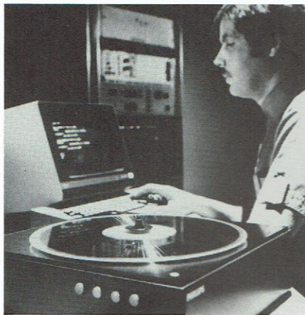
Ny pladehukommelse baseret på det af PHILIPS udviklede diode-laser system. På en dobbeltsidet plastik-plade kan registreres og fremhentes 10 milliarder bits, svarende til 500.000 maskinskrevne A4-sider. Tilgangstid gennemsnitlig 260 ms. Philips har allerede givet udnyttelsesrettigheder til andre datamaskine-producenter. Man har derfor lov til at regne med, at standards allerede er etablerede forinden produktet om få år kan forventes på markedet.
