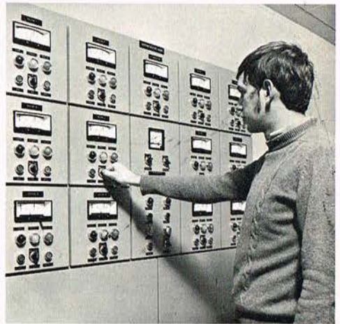
Tekniker Per Karlsson ved en af sektionerne for opvarmningssystemet, som altid holder antennen isfri (konstant + 4°).
