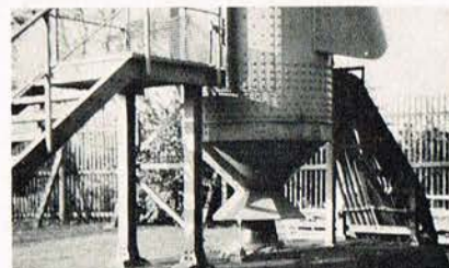
Herover: Mastens fod, isoleret fra jord. Herunder: NDR sender grammofonmusik — men kun pr. båndkopi af moderbåndet.
