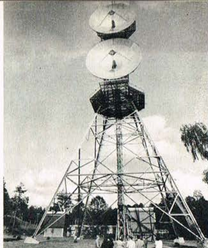
Vesttyskerne må selv foretage forbløffende krumspring af politiske grunde for at overføre TV mellem BRD og Berlins vestlige sektorer. Det foregår ved et scattersystem, hvor man på Schäferberg i Vestberlin udstråler overdådige feltstyrker skarpt rettet mod et punkt i Harzen.
