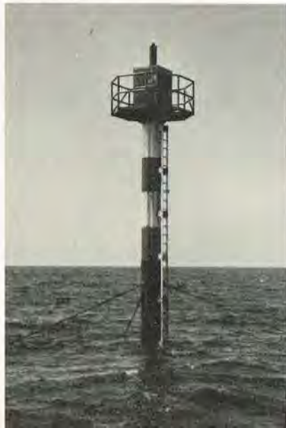
Målestation Mano-Vest for montagen af udstyret blev påbegyndt.
