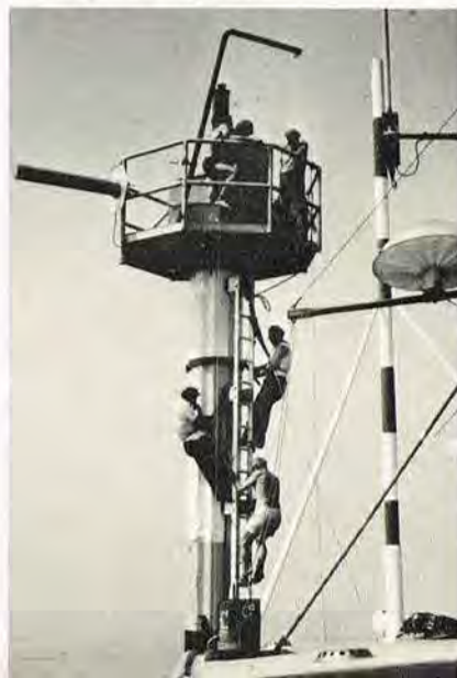
Her ligger opmålingsfartøjet »Digi« ved Mano-Vest, der er under montage med digital vandstandsmåler og bølgemåler. Stromforsyningen er en Lubing vindkraftgenerator.
