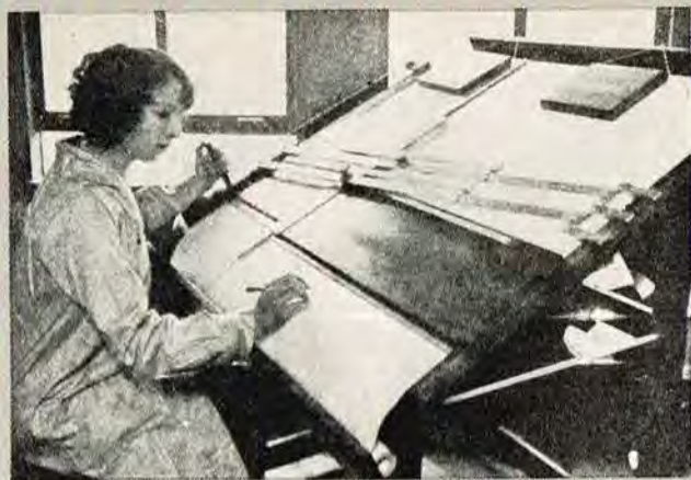
Fremstilling af masterrullen er en tidskrævende proces. På billedet ser vi det brede målebånd for de enkelte toners anslagsstyrke og disse skal nu overføres til huller i selve masterrullen.
