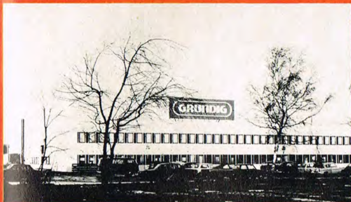
Langsiden af det nye GRUNDIG-hus, som er bygget på en 13.472 kvm stor grund i Tåstrup lige ved Klovtoftekrydset.
