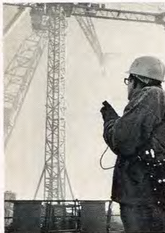
En tæt tåge hindrer ikke mulighederne for at arbejde på værftet. Her er en arbejdsleder, der fra dækket af en nybygning dirigerer én af de store enheder på plads. Stationen han bærer over skulderen fylder ikke meget.
