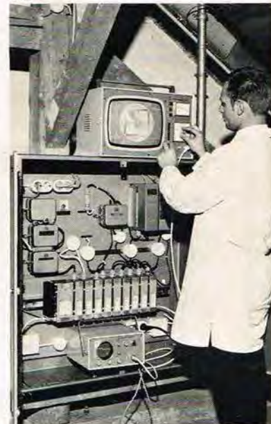
Et fællesantenneanlæg måles igennem.
