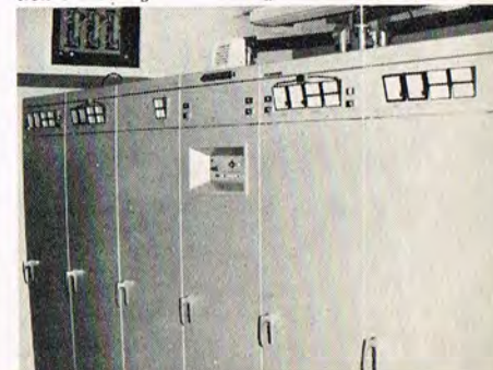
Tv-billedsenderens udgangseffekt-forstærker. Nærbilledet af »dyppekogeren« viser selve effektretet, der afgiver 95 kW udstrålet effekt.
