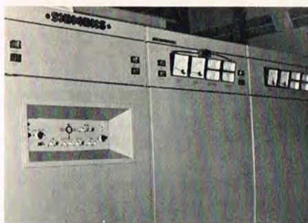
Disse funktionssvigt vil kunne aflæses på denne kontroltafle, der også indikerer, hvilken af de to sendere, der er i gang i øjeblikket.
