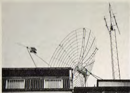
Her ses parabolen fra bagsiden. Den vejer 400 kg og består af aluminiumrør.
