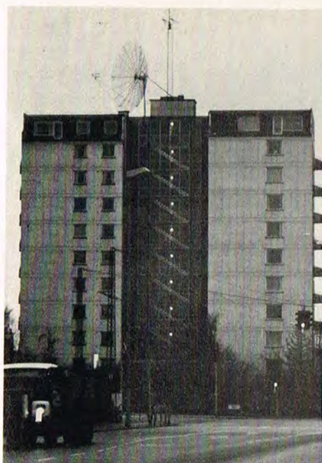
Højhuset med den monterede parabolantenne, der blev »hejset« op ved hjælp af en helikopter.
