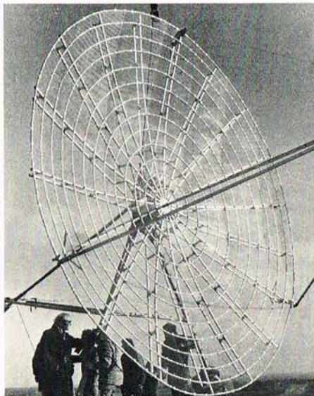
Den store parabolantenne placeret på siloen i Solrød, hvor den kunne hente tv-signaler fra vort sydlige udland. Man forsøgte dog kun fra »Bundesrepublikken«; det havde været interessant, hvis man også havde set billeder fra DDR.
