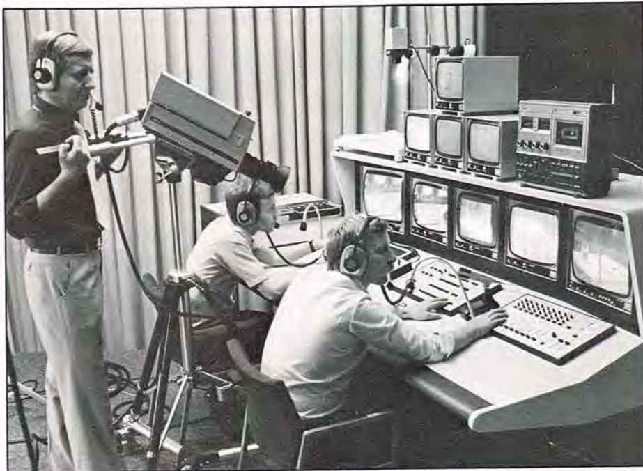
De modulopbyggede mixere fylder ikke meget, idet hovedparten forsvinder ned i hovedpulten. Her ses en lydmixer, som på det store billede er placeret yderst til højre.
