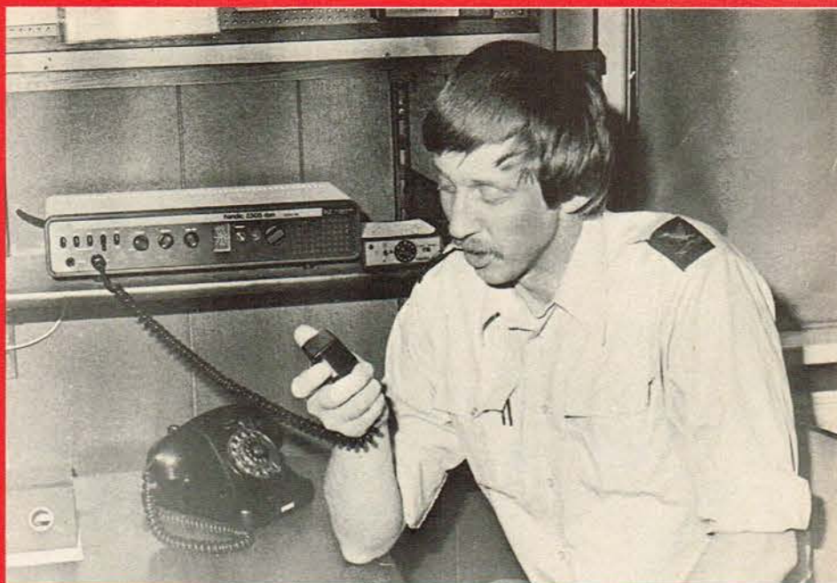
Privatradiostation for overvågning på en Falck-station. Dette billede er fra Korsør.
