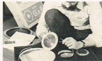
Ledningerne fra terminalboks/delefilter forbindes til enhederne, hvorefter disse skrues fast.
