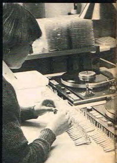
I denne fase af produktionskontrollen sorteres den største mængde af pick-up'er fra, såvel dem der lider af tekniske men også ydre
