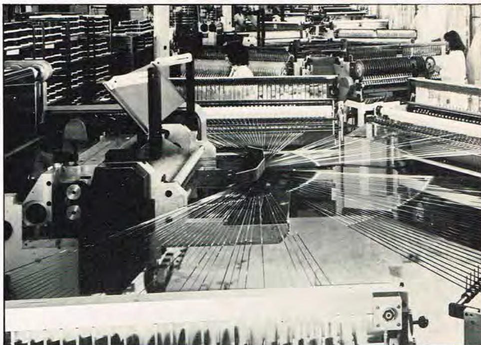
I store skæremaskiner skæres båndene til i den rigtige bredde, og spoles op. Spolerne løber derefter igennem en slettekanal, hvori en eventuel formagnetisering slettes, — i princippet den samme slette-metode som i recorderen.
