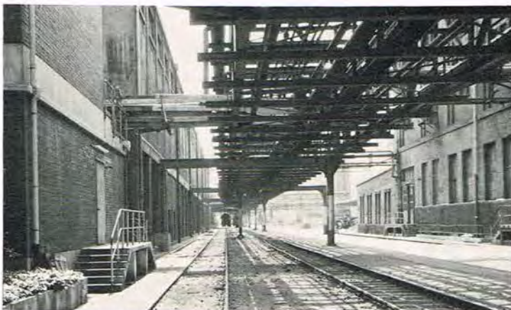
1600 bygninger, 203 km jernbanespor, 103 km vejanlæg og 2000 km rørsystem over jorden, hvoraf du ser en lille bid her, er nogle af de imponerende tal fra BASF's fabriksanlæg i Ludwigshafen.
