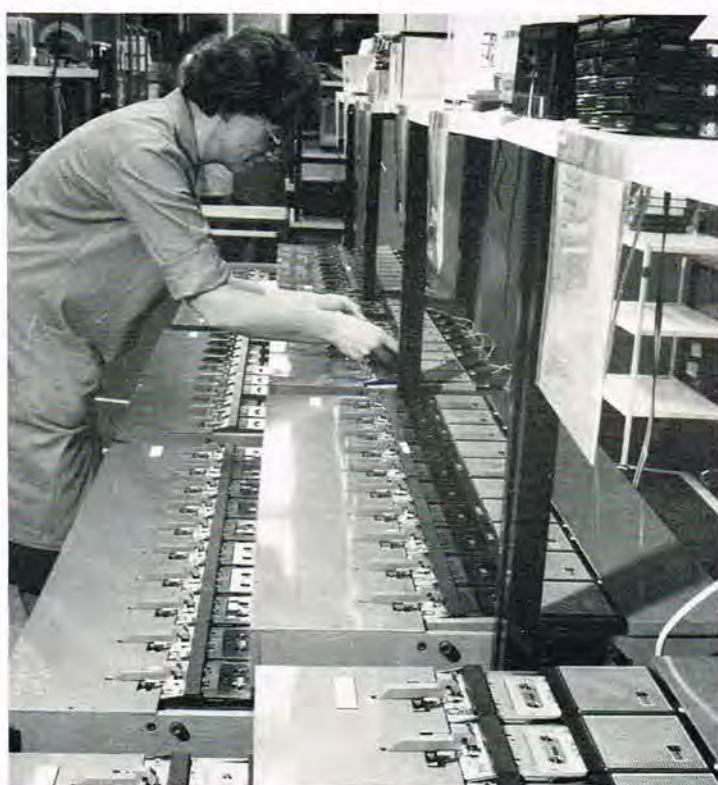
Også kassettehusene kontrolleres for hvert enkelt trin i fremstillingsprocessen. Her checkes spolemekanismen.
