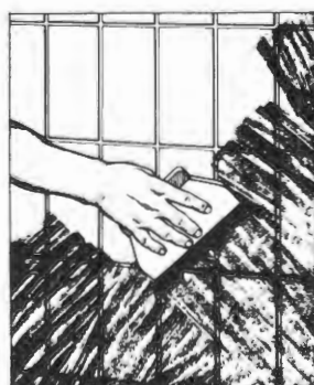
Udfugning ved hjælp af gummispartel
