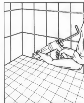
Elastisk fuger i hjørner og omkring gulv
