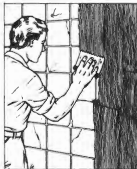
Pasta påføres med tandspartel
