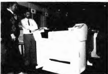
Her ses en plotter af den vertikale type, bruges på steder med meget høj husleje.
