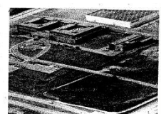
Sparekassernes Datacenter (SDC) i Ballerup
